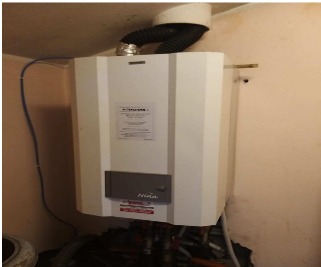
Caldaia a gpl a 25.9kw al piano 2° soffitta
